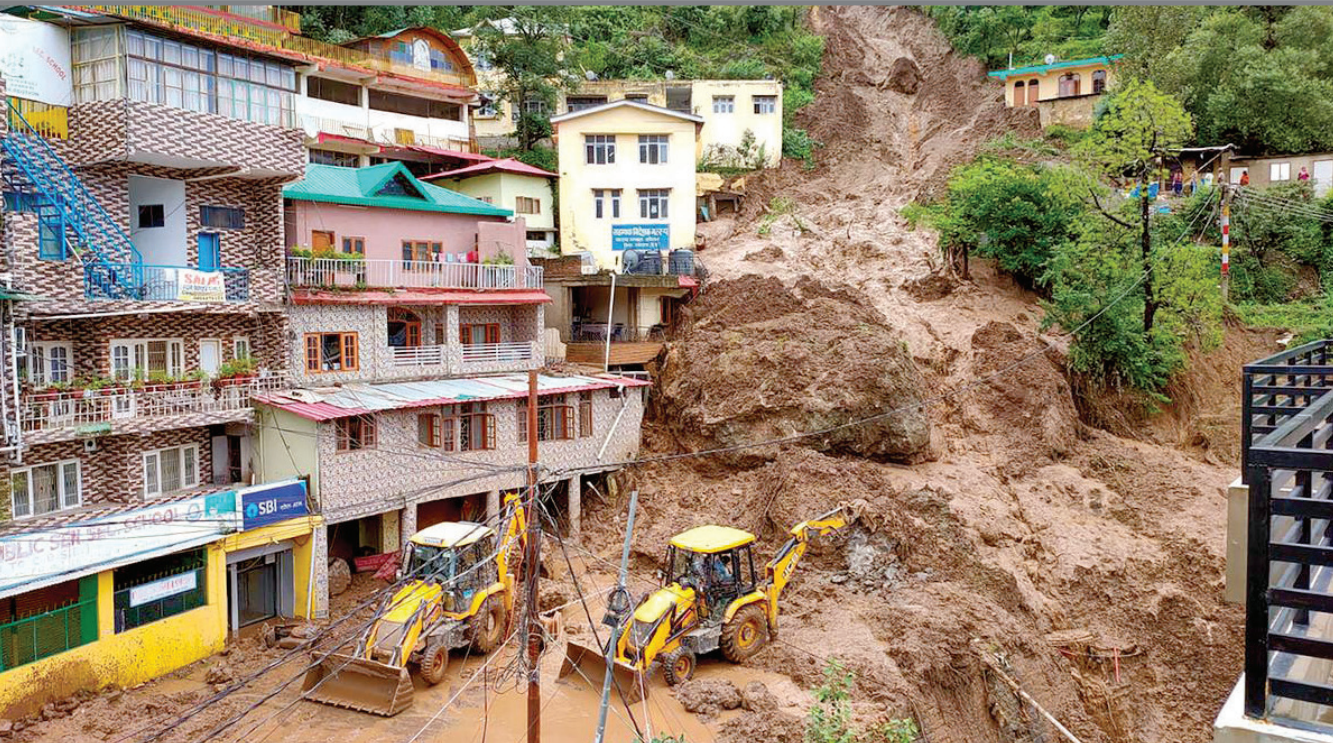
आपदा सोलन जिले के शमती में भूस्खलन से क्षतिग्रस्त इमारतों के पुनर्निर्माण में लगे अर्थमूवट।
