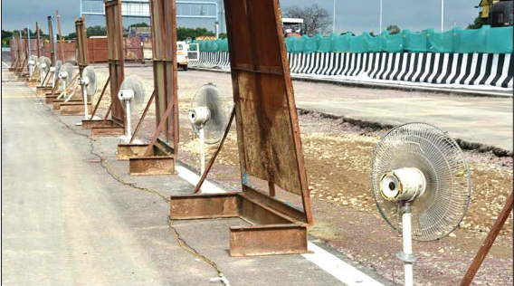
उद्घाटन के साढ़े तीन महीने बाद गंगा एक्सप्रेस-वे पर बना गहरा गड्ढा और उद्घाटन के 13 दिन बाद लखनऊ-कानपुर एक्सप्रेस-वे पर पड़ी दरारें (ऊपर) और गौली जगहों को सुखाते हुए पेडस्टल पंखे एवं दरारों के चारों ओर लगी सावधानी वाली टेप
