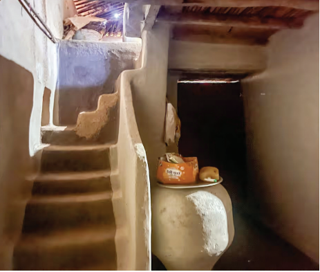
पारंपरिक गोंड घर की छत जो मिट्टी की खपरैलों, लकड़ी की बल्लियों और बांस से बनी है। केदारनाथ का पक्का और उनके माता-पिता द्वारा बनाया मिट्टी का घर। (ऊपर) भवान पर रत्नी कुंभनी के साथ तिवेंद्रम और मिट्टी की बनी सीढ़ियों को पहली मंजिल तक जाती हैं
